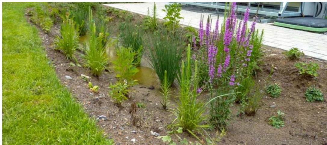
Abb. 36: Retentionsmulde (Quelle: Bayerische Landesanstalt für Weinbau und Gartenbau - Pflanzen für Versickerung und Retention“)
